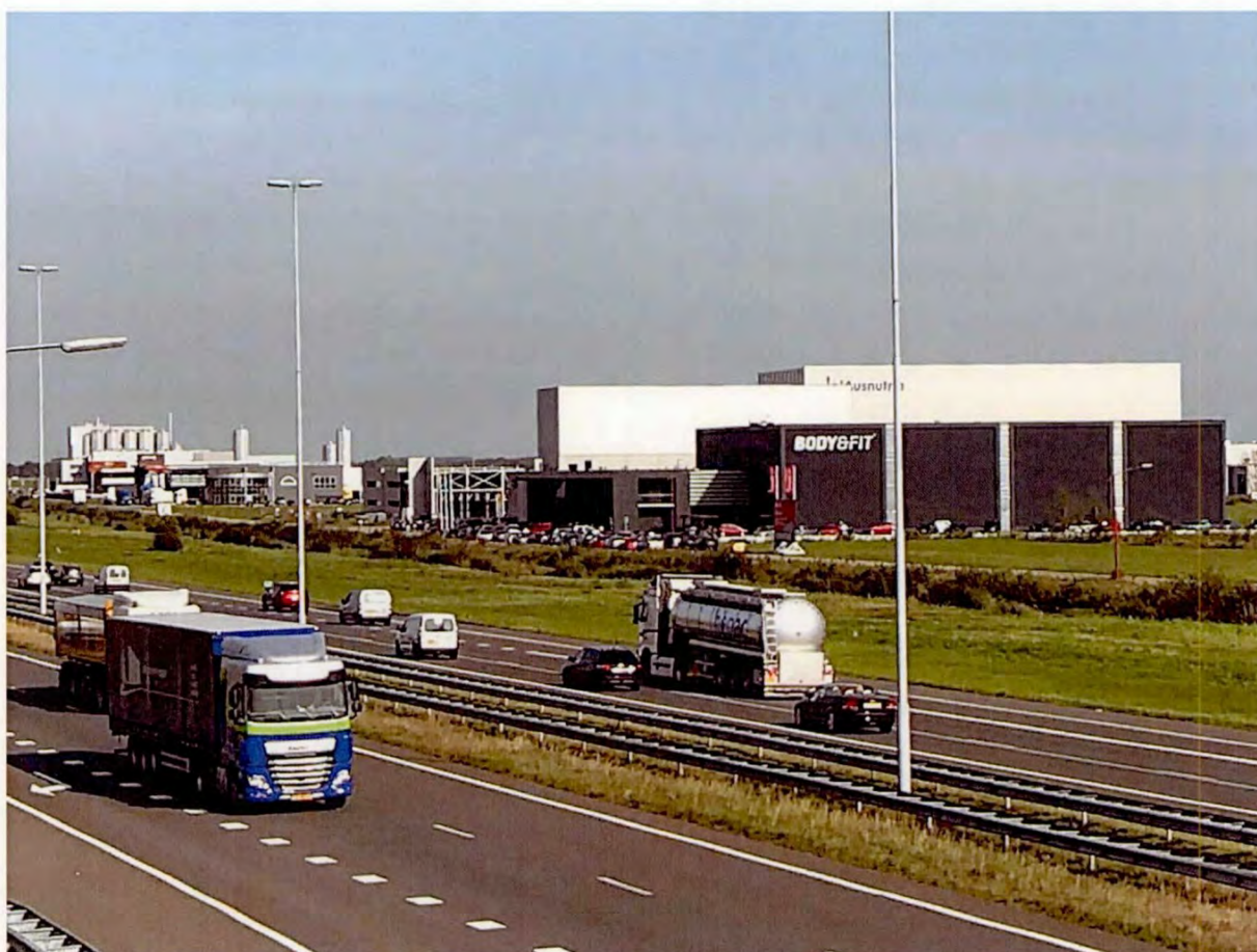
Foto 5: Internationaal Businesspark Friesland (IBF) Heerenveen gezien vanaf het viaduct Mercuriusweg over de A7.
