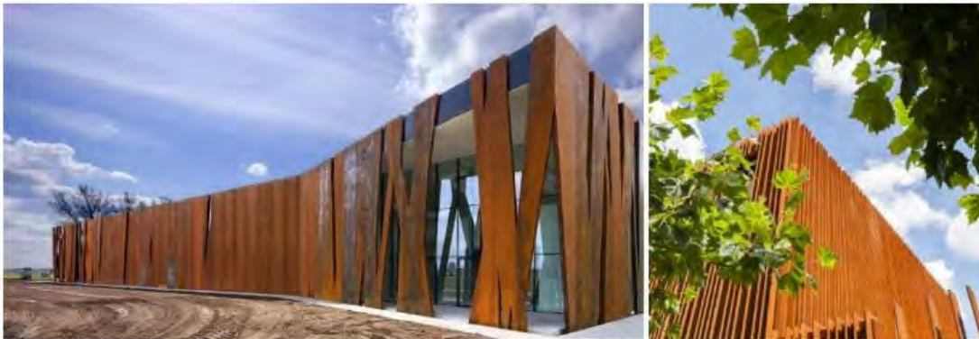
Figuur 6.3 Cortenstaal met verticaal karakter. Sterk Gorredijk, Sluimer en van Leeuwen architecten (links) en DMOA (rechts)
